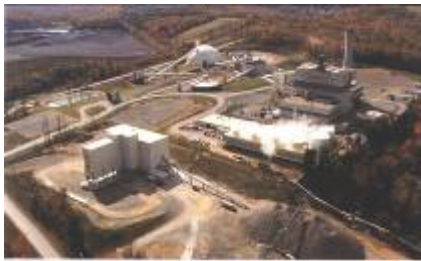
88 MW Ebensburg (Cambria), PA USA
