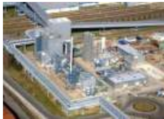
Vattenfall Schwarze Pumpe Germany - 30 MWth Oxy - Lignite
